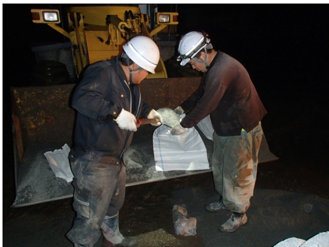
土のう製作状況-1
