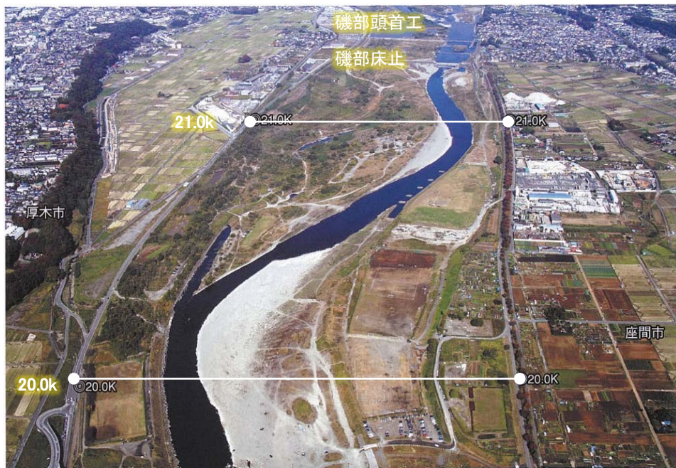
磯部頭首工の下流側の状況
