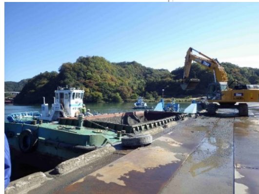
相模ダムにおける浚渫状況
