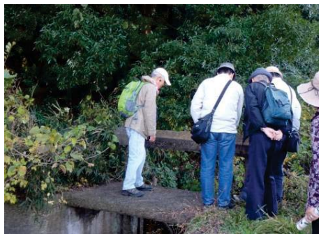
昭和12年竣工の栗山の堰。何故か、この時代では珍しいローマ字で刻まれている。
