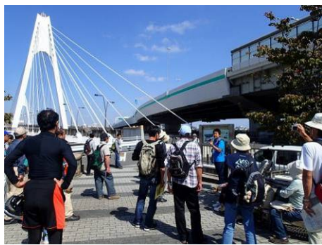
大師橋の説明の様子
