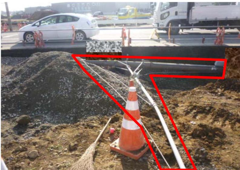
・交差点拡幅工および路床置換工に伴う掘削作業を行っていたところ、警察所有の車両感知器および二輪車専用押しボタン付きのコンクリート柱を転倒させた。
