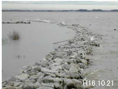
突堤工による消波状況 (境島（上流）地区(捨砂工区))
