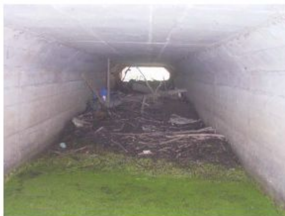
平成18年9月 樋管内部の粗朶流入状況
