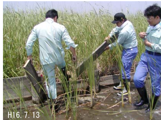
H16.7.13 植生の繁茂により裸地的環境が消失したため、板柵の撤去作業を実施
