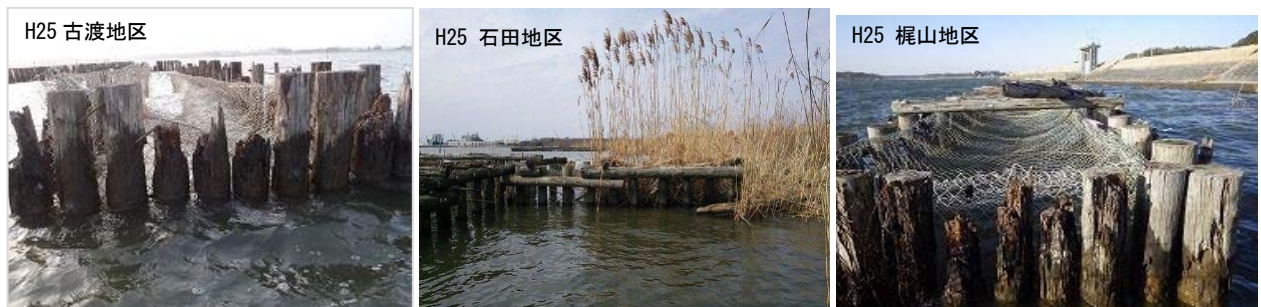
図 7.1-2 粗朶消波工損傷状況
