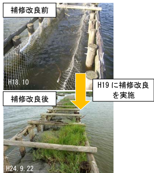
図 7.1-7 袋詰根固による粗朶消波工の補修改良（境島地区）
