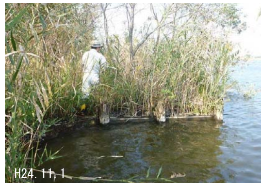
H24.11.1 板柵工の内側は盛土工が行われており、ヨシやヤナギが生育・繁茂している。
