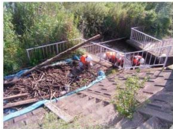
平成18年9月 樋管からの粗朶撤去作業状況
