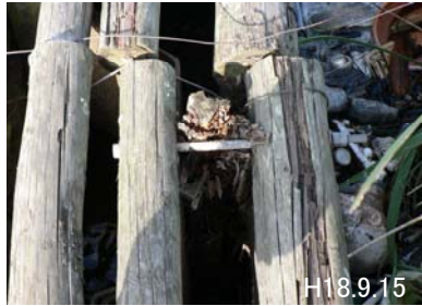
H18.9.15 矢板式突堤工の上部の木杭が腐食 (石川地区)
