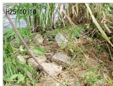
人工バーム上には植生が繁茂している
