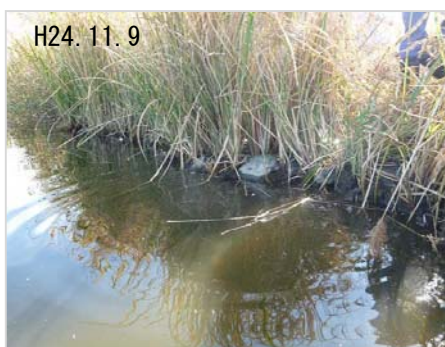
人工バームの前面の水際部は、波浪の侵食により水深が深くなっている
