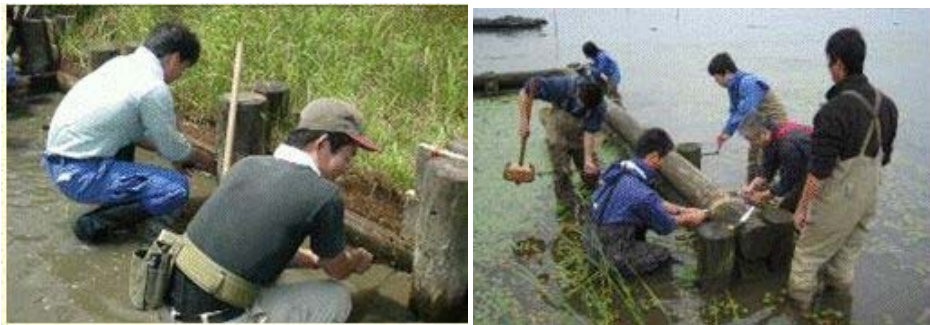
図 7.3-6 消波構造物の試験的な撤去
