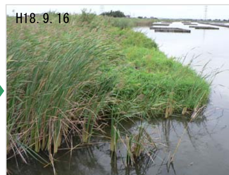
人工バーム上に植生が繁茂した
