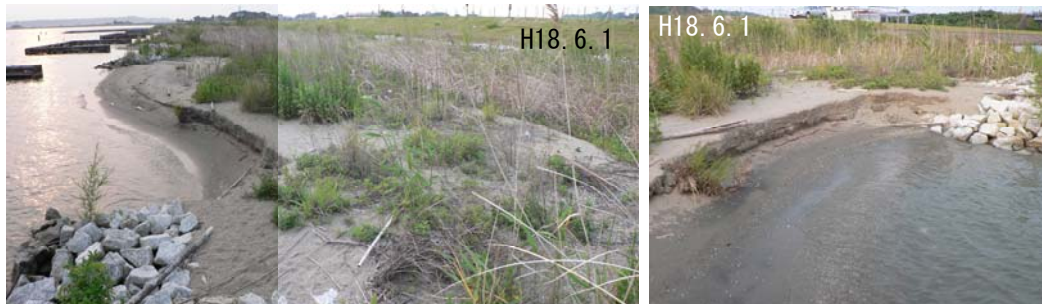
人工バームの無い箇所は養浜水際の砂が侵食されている
