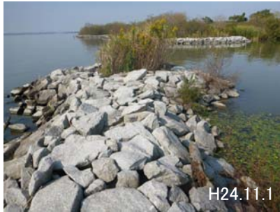
石積式突堤工（根田（上流）地区）
