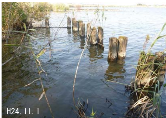
H24.11.1 湖岸に設置された板柵工は、水面より上部の横板が無く、下段の横板のみが残っている。水域となっており、裸地は見られない。
