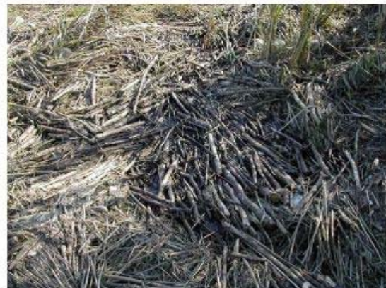
平成16年10月 台風22号高水位後 内蔵粗朶大量に流出（石川地区）
