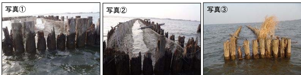
図 5.2-9 平成 25 年度 粗朶消波工の様子
