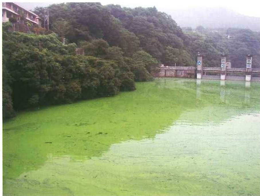
アオコの異常発生（相模ダム）
