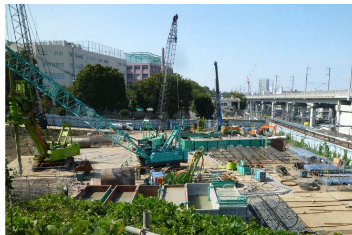
写真a 杭工事施工状況
