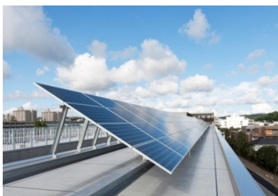
太陽光発電設備の例
