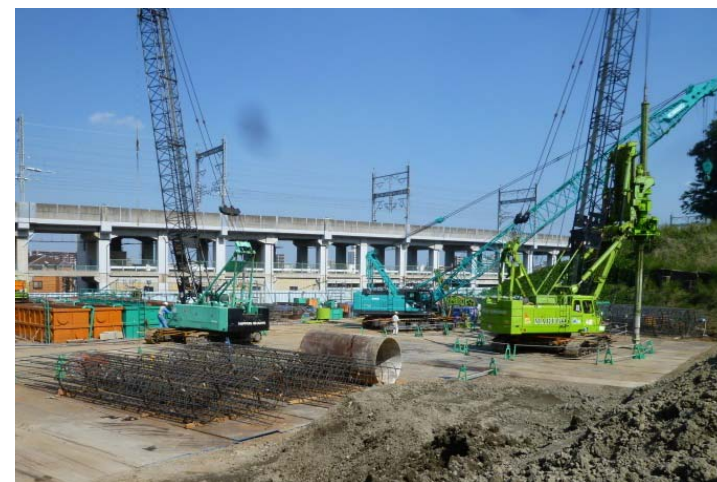
写真b 杭工事施工状況
