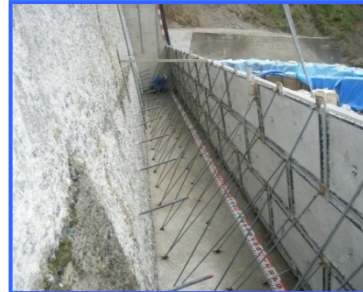
残存型枠工法
