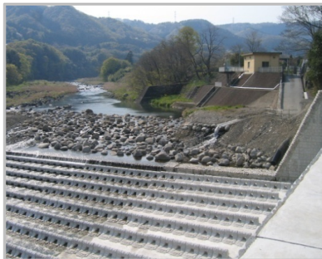
神梅1号床固工
