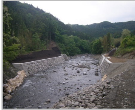
関守5号床固工
