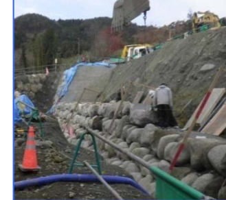
巨石積み護岸工法
