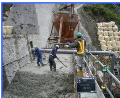
従来工法(コンクリート打設)
