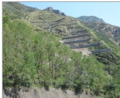
山腹工の施工例
