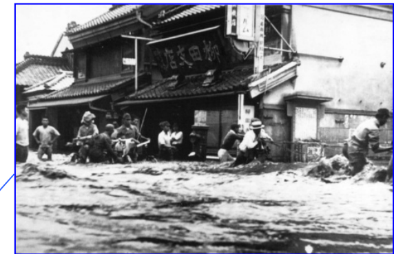
足利市の被災状況 (昭和22年カスリーン台風)
