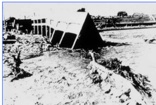
桐生市の被災状況 (昭和22年カスリーン台風)
