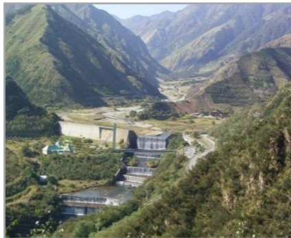
砂防堰堤の施工例
