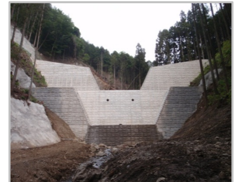
日暮沢1号砂防堰堤
