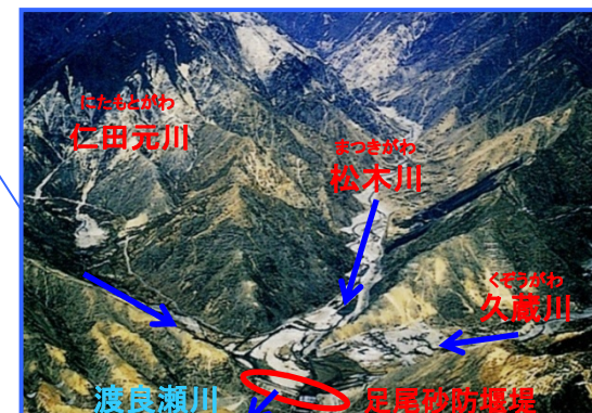
足尾地区の荒廃地
