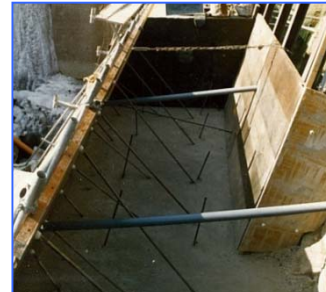
従来の型枠使用による工法
