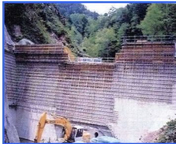
従来工法(普通型枠)
