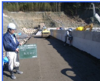
INSEM材締固め状況
