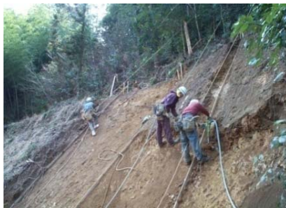
従来工法(人力土工)
