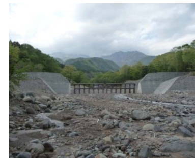
堤体の一部に砂防ソイルセメントを使用した天狗沢下流第1砂防堰堤
