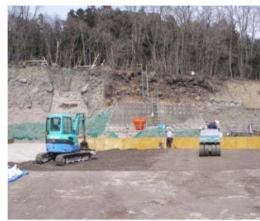
砂防ソイルセメントを敷均し・締固
