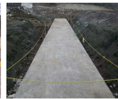
砂防ソイルセメント施工部分の完成状況
