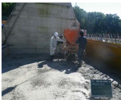
従来工法(コンクリート打設)
