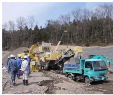
現地発生土砂とセメントを現地で混合し砂防ソイルセメントを製造
