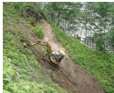
無人化施工機械による土工
