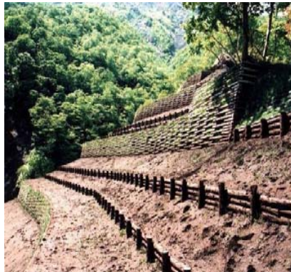
山腹工の例(大雑山腹工) おおなぎ
