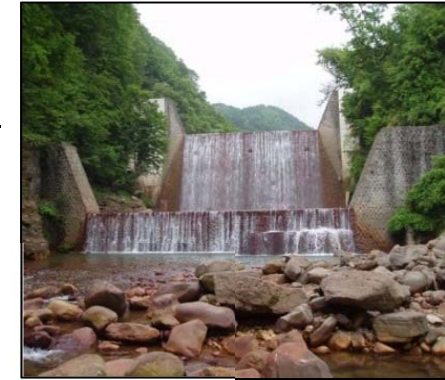
砂防堰堤の例 まんざがわ (万座川第二砂防堰堤)
