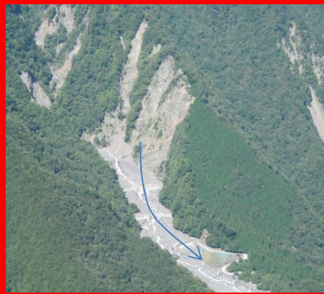
早川上流の荒廃地からの土砂生産
