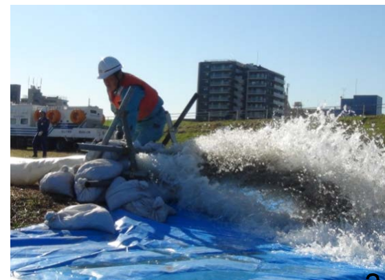
◆排水ポンプ車による排水
