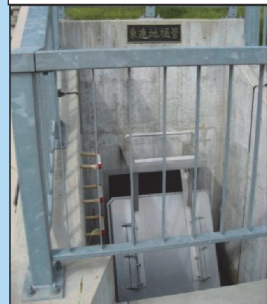
②整備後の状況：排水樋管
