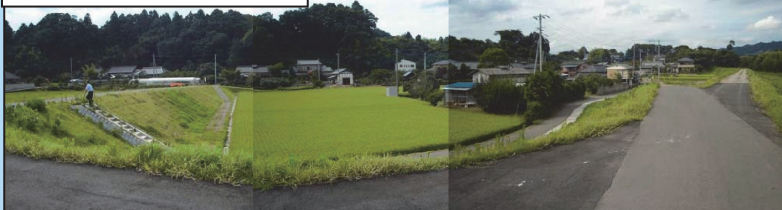
①整備後の状況：堤防
