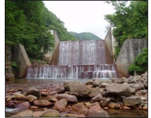
砂防堰堤の例
