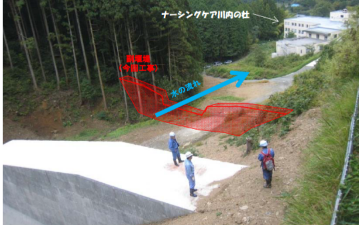
写真-3 大久保沢砂防堰堤(本堤)から下流を見下ろす=10月9日午後
