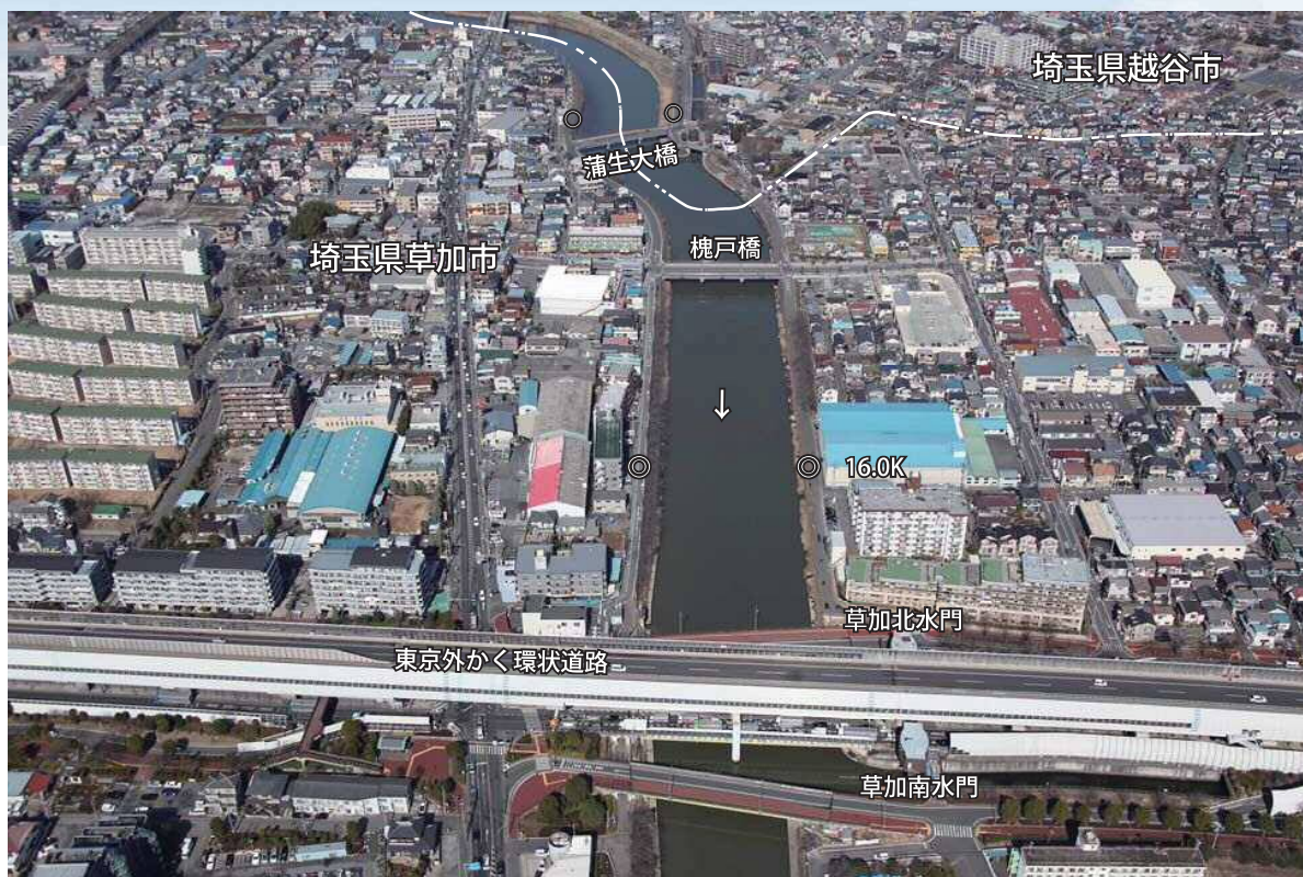
▲草加北水門・・・鋼製ローラーゲート 純径間 11.0m × 扉高 6.87m × 1 門 昭和 63 年完成 草加南水門・・・鋼製ローラーゲート 純径間 11.0m × 扉高 6.87m × 1 門 平成 3 年完成
