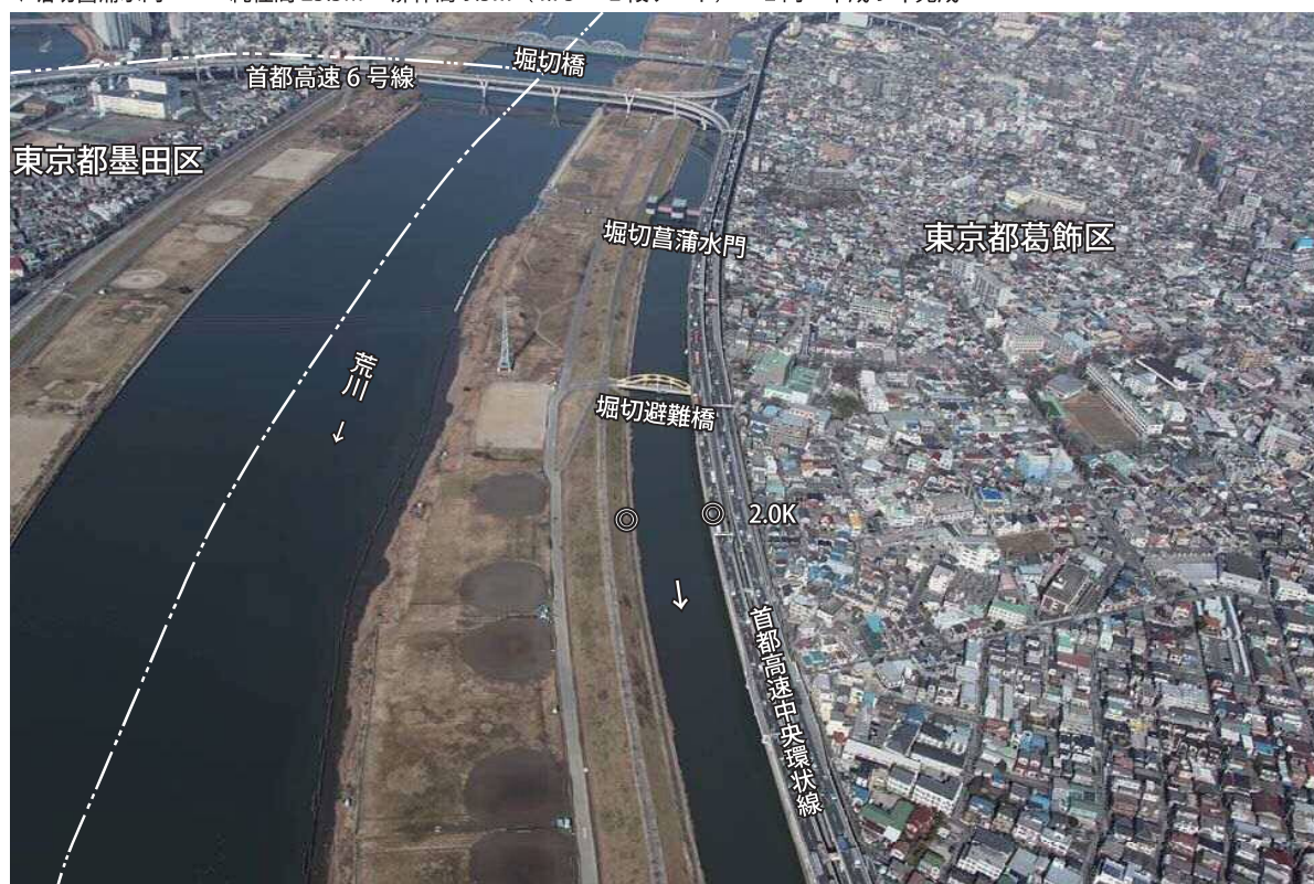
▼堀切菖蒲水門・・・純径間 25.5m × 扉体高 9.5m (4.75 × 2 段ゲート) × 2 門 平成 9 年完成
