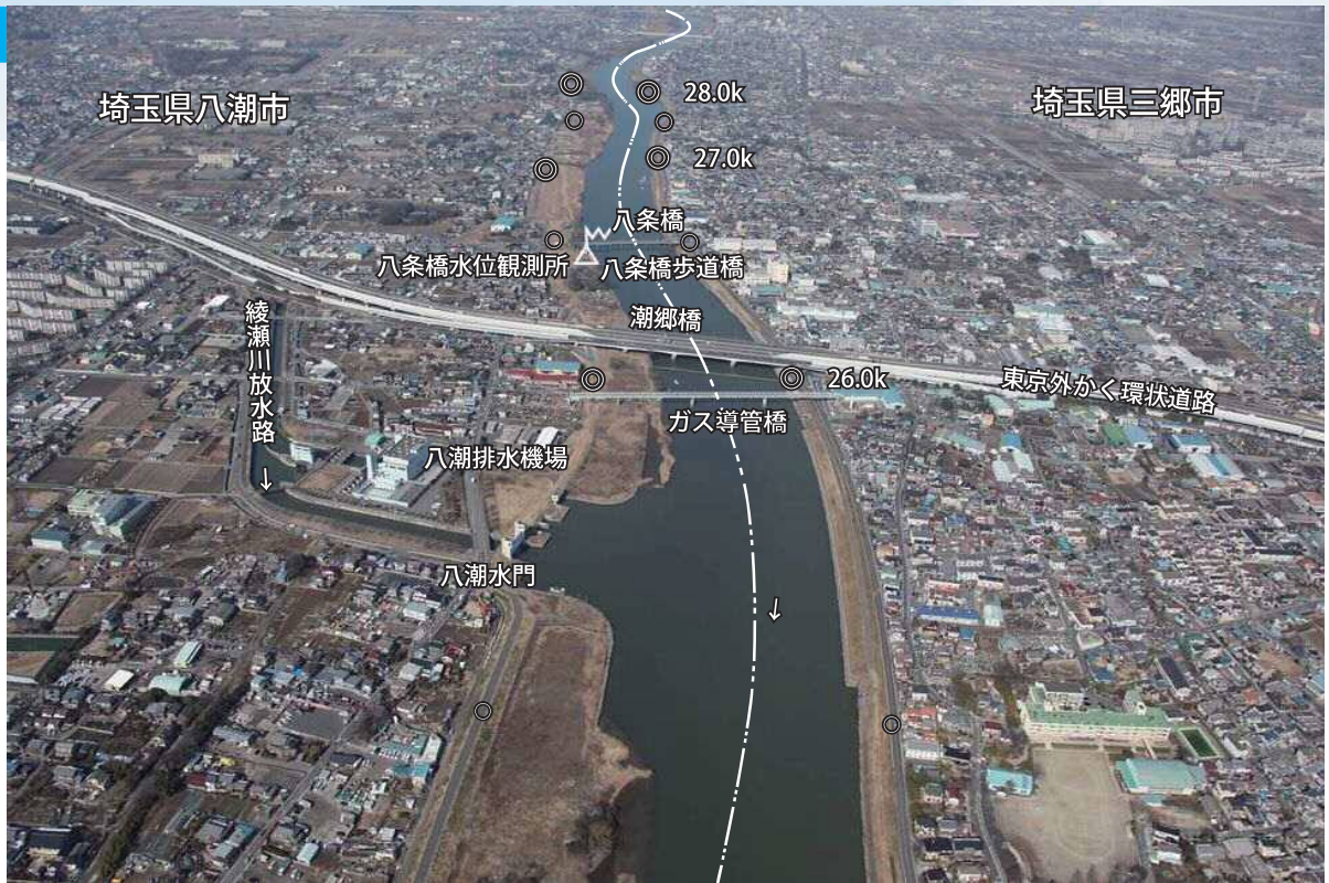
▲八潮排水機場・・・排水量 100 \text{m}^3/\text{s} (25 \text{m}^3/\text{s} \times 2 台 + 50 \text{m}^3/\text{s} ) 八潮水門・・・鋼製ローラゲート 純径間 22.1m \times 扉体高 9.252m \times 1門 昭和 62 年完成
