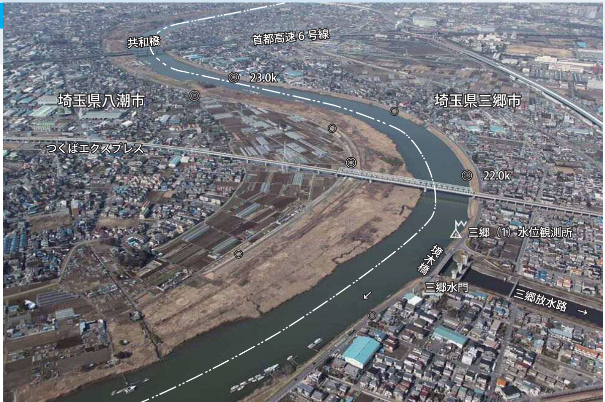
▲三郷水門・・・鋼製ローラゲート 純径間 22.0m × 扉体高 7.38m × 2門 昭和 49 年完成
