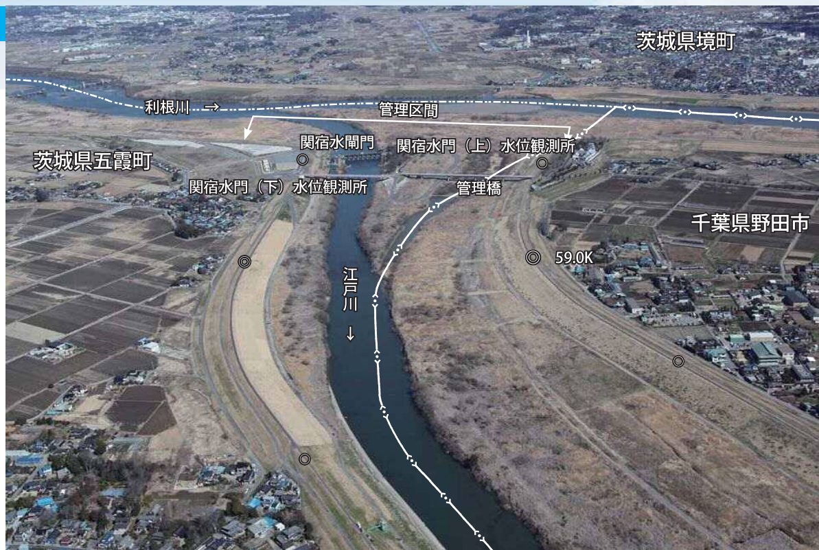
▲関宿水閘門・・・水門：ストーニ式鋼製ゲート 純径間 8.54m × 扉体高 4.7m × 8 門 昭和 2 年完成 閘門：合掌式鋼製ゲート 純径間 8.5m × 扉体高 4.92m × 2 門 昭和 2 年完成
