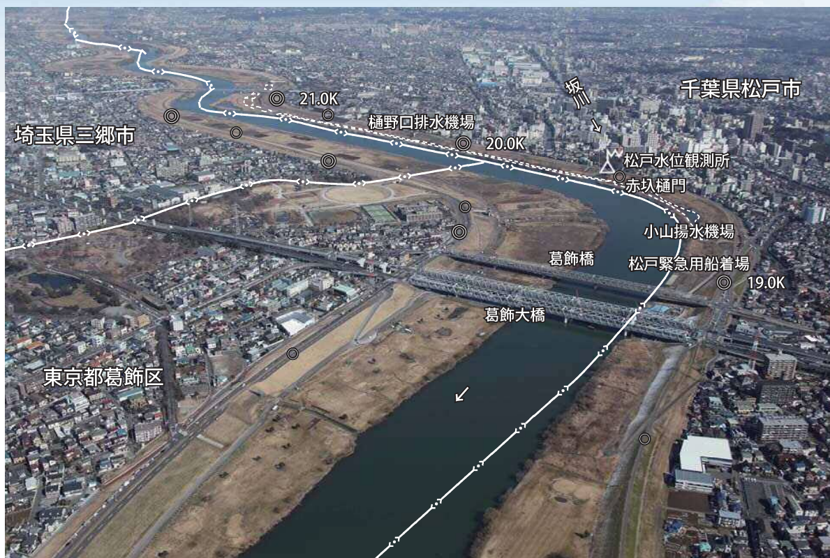
▲草赤坎樋門・・・高 2.5m × 幅 4.4m + 高 31.05m × 2 門 昭和 5 年施工 昭和 32 年増設 樋ノ口排水機場・・・排水量 25m 3 /s
