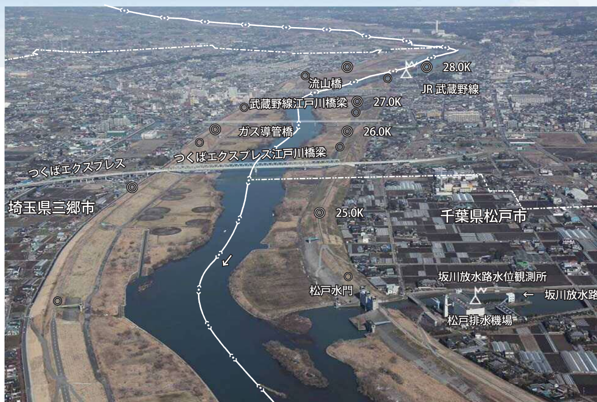
▲松戸排水機場・・・排水量 100m 3 /s (50m 3 /s + 25m 3 /s × 2台)
