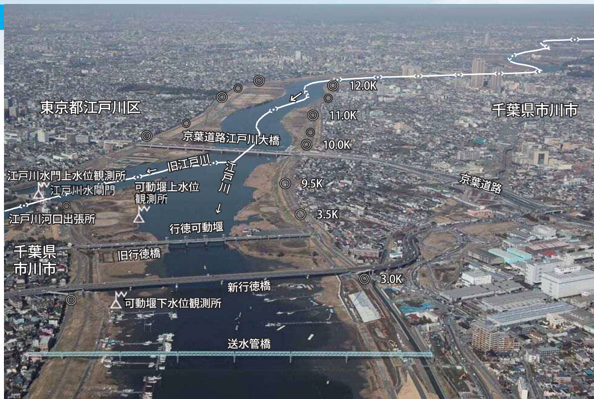
▲行徳可動堰・・・鋼製ローリングゲート 純径間 30.0m × 扉体高 5.0m × 3 門 昭和 32 年完成
