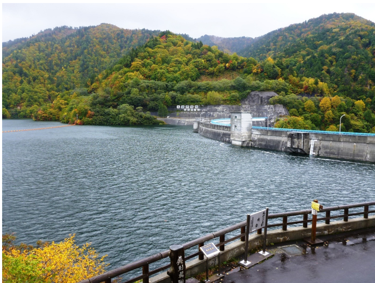
矢木沢ダム（平成26年10月14日撮影）
