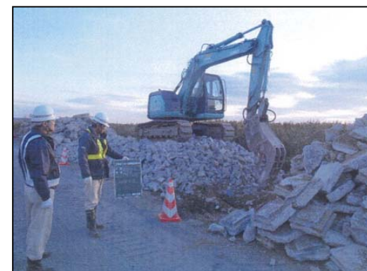
護岸等のコンクリート破碎状況
