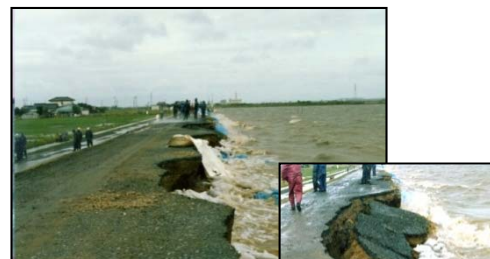
かとりし さんのわけめ 香取市三之分目地先の堤防洗掘被害状況
