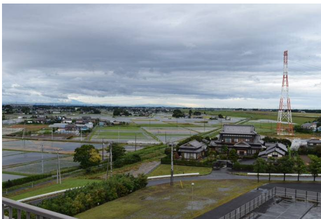
10月6日12時 庄和排水機場背後地状況
