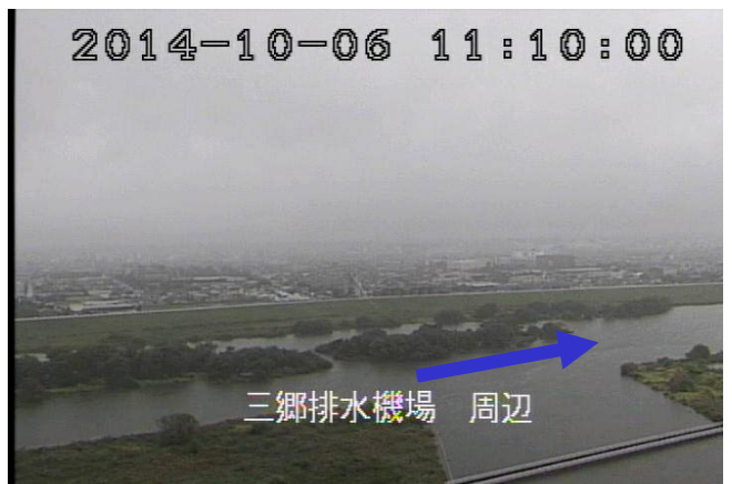
10月6日11時 三郷排水機場周辺状況
