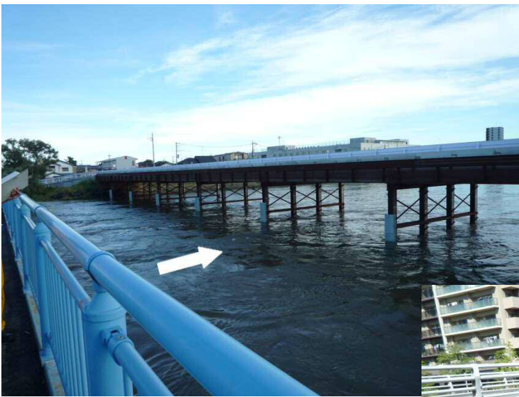
吉川橋付近出水状況
