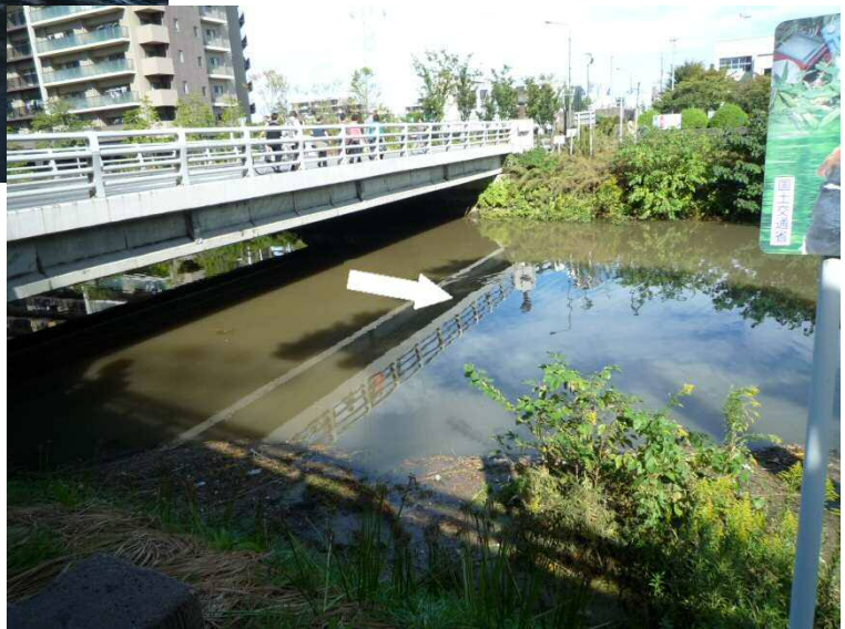
綾瀬川松原大橋付近出水状況
