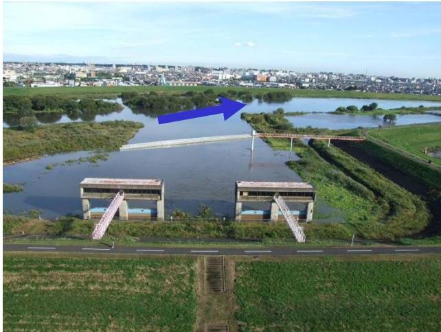
10月6日15時 三郷排水機場周辺状況
