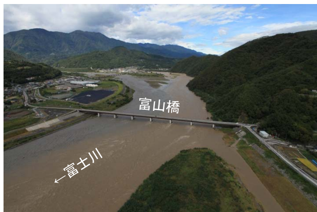
④富山橋(山梨県身延町波高島)上空 (平成26年10月6日 11:35)
