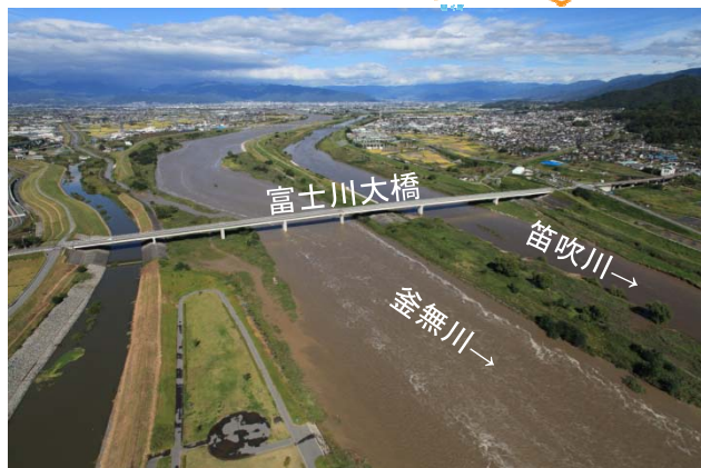
②富士川大橋(山梨県富士川町増穂)上空 (平成26年10月6日 13:27)
