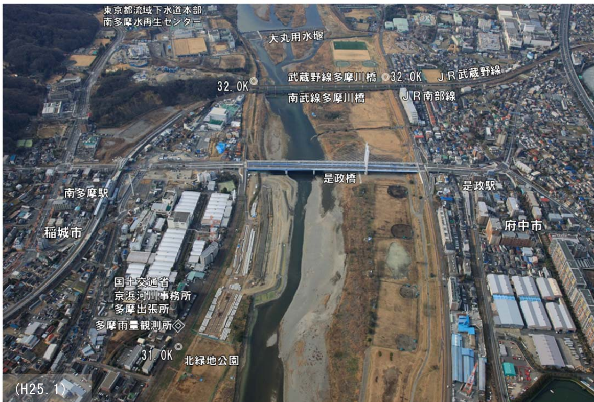
河口から 31km 付近
