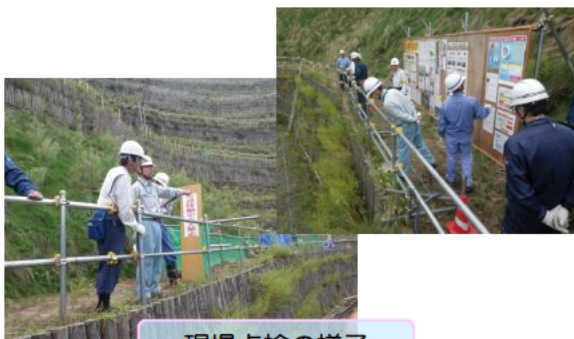
現場点検の様子
