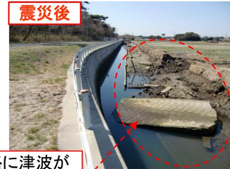
堤内水路に津波が逆流し、護岸が崩壊
