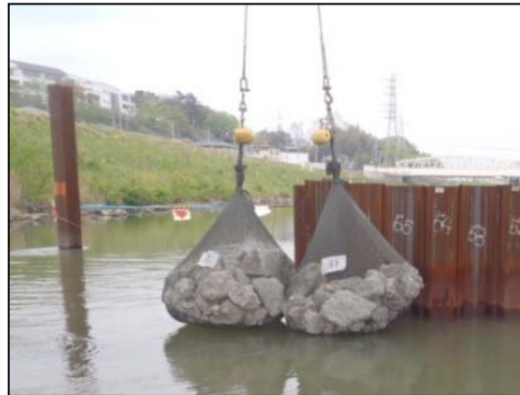
撤去ガラを袋詰め根固めとして再利用
