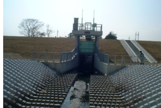
下大野第三排水樋管(右岸4.0k+212m)
