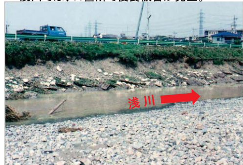
浅川6.0k左岸侵食被害状況
