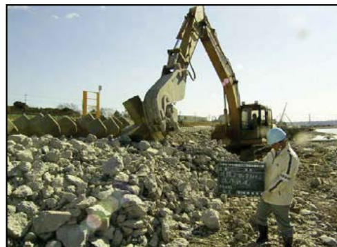
根固めブロック(2t)破碎状況 コンクリート殻量=約12,234m 3
