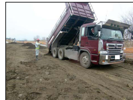
盛土材の搬入状況
