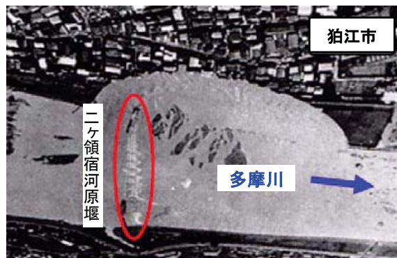
ニヶ領宿河原堰付近堤防決壊状況
