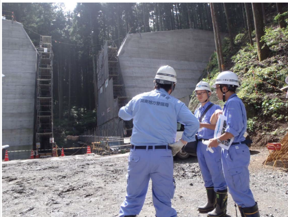
写真-5 現場にて須藤出張所長(左)から工事内容の説明を受ける実習生(右二人) =8月18日
