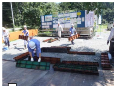
写真-6 型枠の組立作業を開始!!
