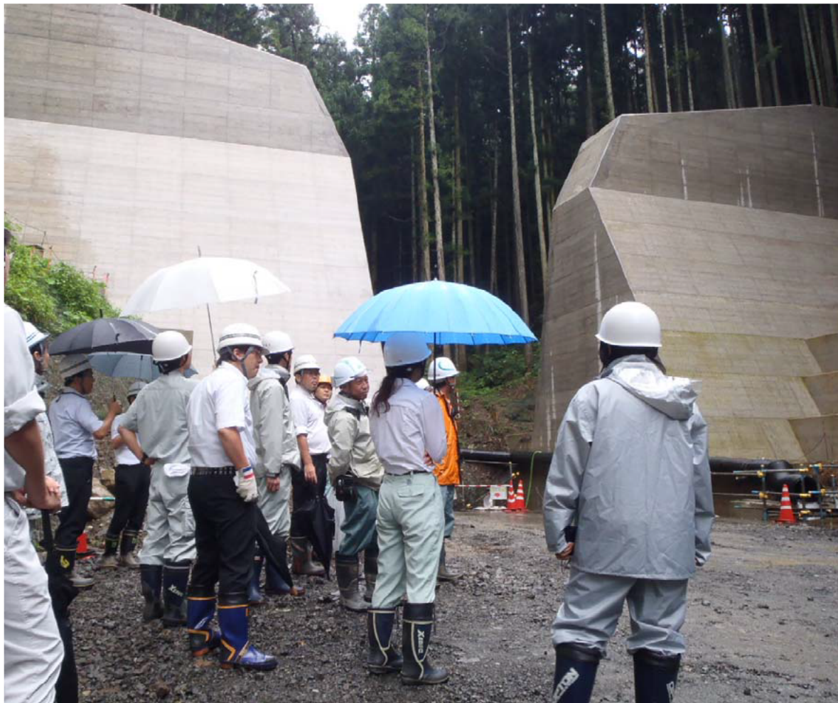
写真-1 現地視察する桐生土木事務所と渡良瀬川河川事務所の職員＝8月26日午後、桐生市川内町、H25日暮沢二号砂防堰堤工事現場にて
