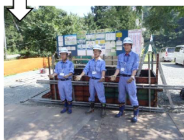
写真-8 型枠の組立作業が完了!!
