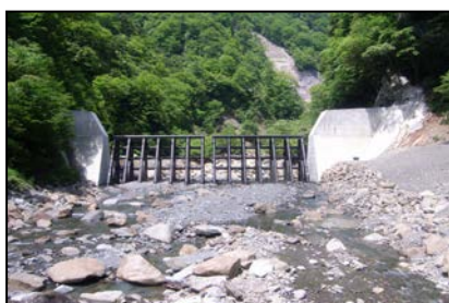
野呂川第四砂防堰堤工事
