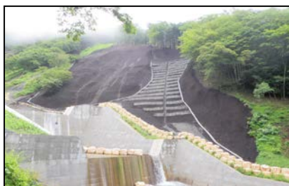
H22メリ沢左岸法面对策工事
