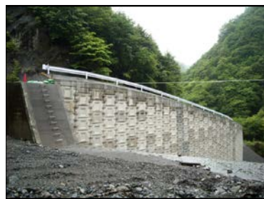
H21黒河内工事用道路工事
