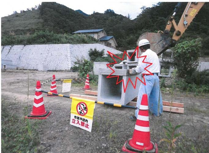
・作業員がU字側溝を現地の寸法に合わせるため、エンジンカッターで切断作業するために、U字側溝の側面を切断しやすいようにバックホウのバケットで倒そうとしたところ、U字側溝と角材の間に右手の中指を挟み負傷した。
