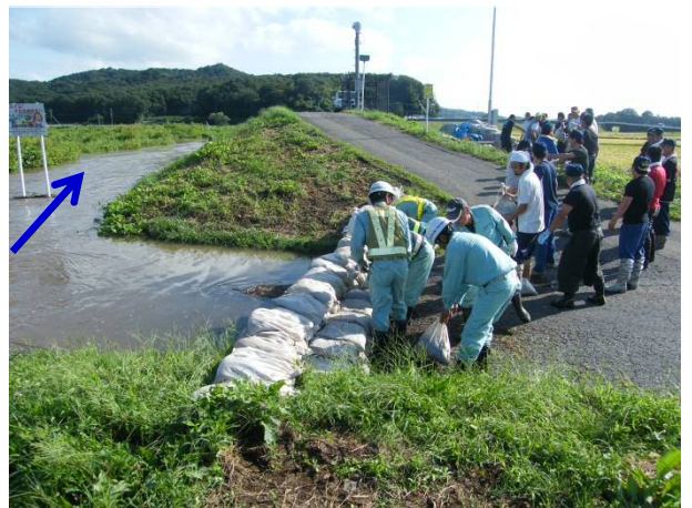
阿部岡橋右岸 土のう積み 15日14:00頃
