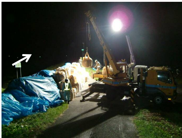
阿部岡橋右岸 大型土のう積み 16日1:00頃
