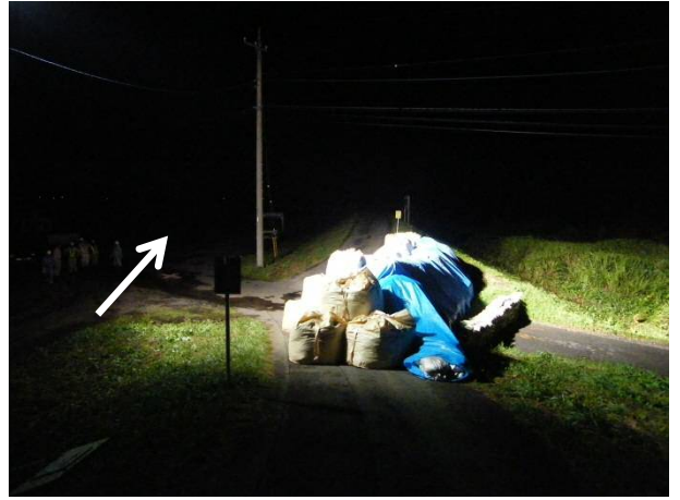
阿部岡橋右岸 大型土のう積み完了 16日2:00頃
