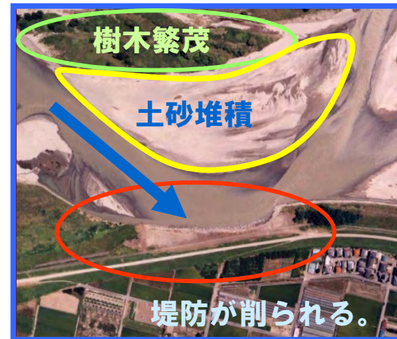
平成15年の洪水で堤防が削られる (釜無川・南アルプス市浅原)
