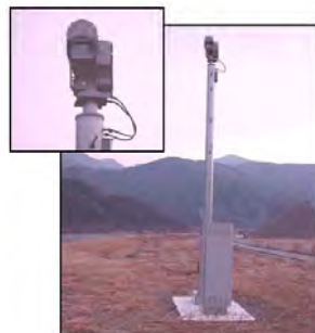
河川監視カメラ
