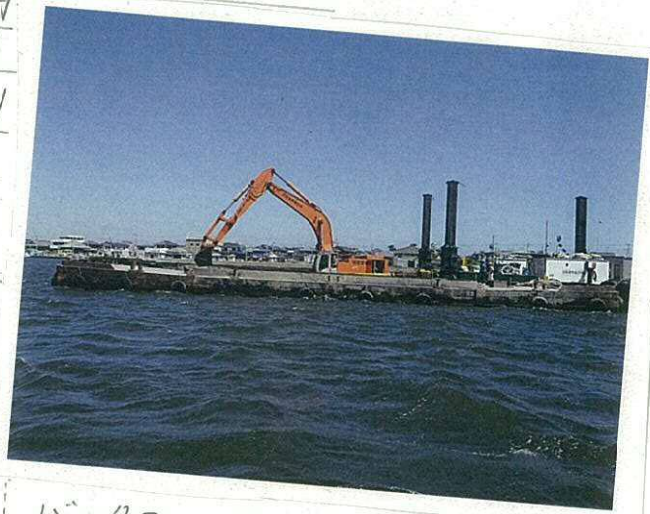
バックホーで川底の土石を除去する
