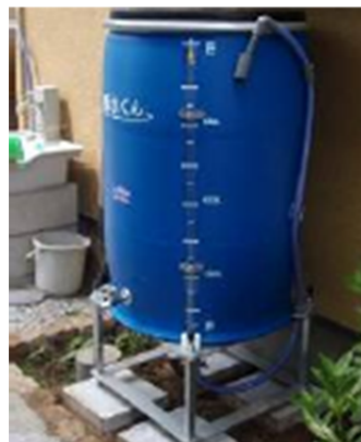
家庭用の雨水貯留タンク
