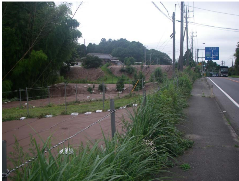
＜写真①＞2車線区間(寺台～東金山) 用地取得状況
