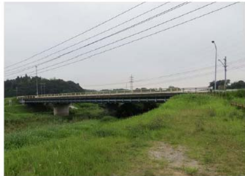
＜写真②＞2車線区間(寺台～東金山) 架け替え予定橋梁(東金山橋)…現在設計中
