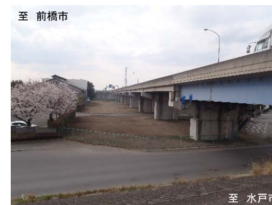
写真①：事業進捗状況写真（新川島橋）
