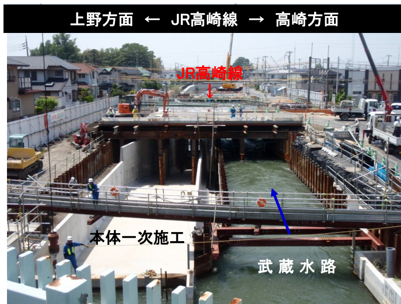
JR区間工事 柳橋付近から下流を望む (水路本体工)
