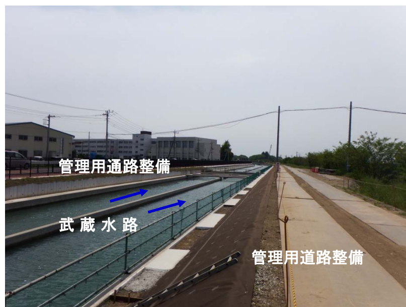
上流部改築工事 赤城橋付近から下流を望む (付帯工)
