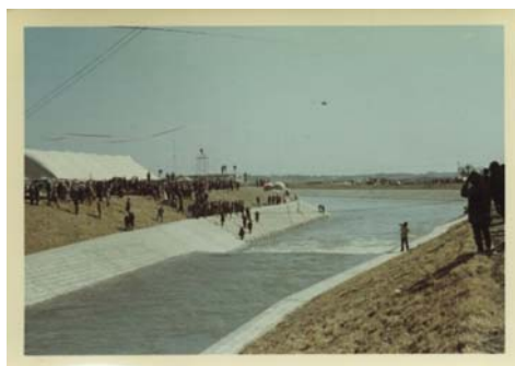
一部導水を開始した武蔵水路 (昭和40年)
