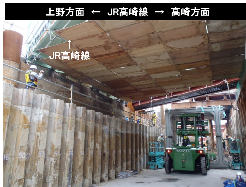
JR区間工事 高崎線直下部から下流を望む (水路本体工)
