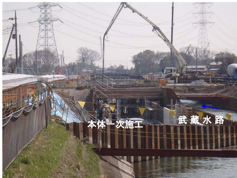
下流部改築工事 旧道橋上流から下流を望む (水路本体工)
