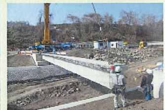
PC桁架設(360t吊クレーンによる)
