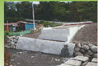
右岸側橋台施工完了
