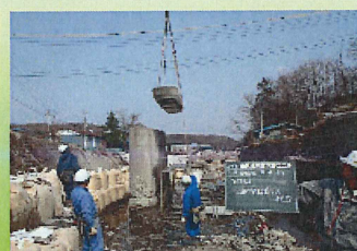
橋脚切断撤去中
