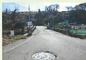
(旧田代橋)左岸側から
