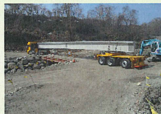
PC桁6本搬入(長さ23.43m 重量28.7t)
