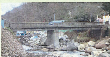
(旧田代橋)左岸上流側から
