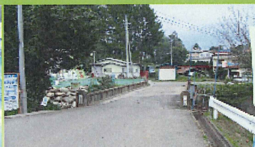
(旧田代橋)右岸側から
