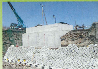
左岸側橋台施工完了
