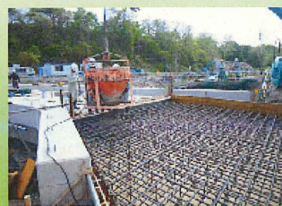
左岸コンクリート打設
