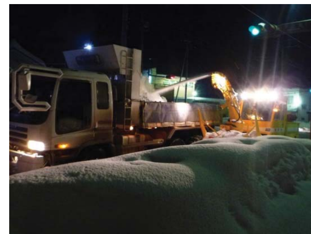
【(国)120号（群馬県管理）夜間排雪作業（H26.2.16撮影）】
