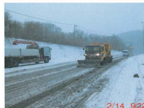
除雪トラックによる除雪作業状況(初期段階)
