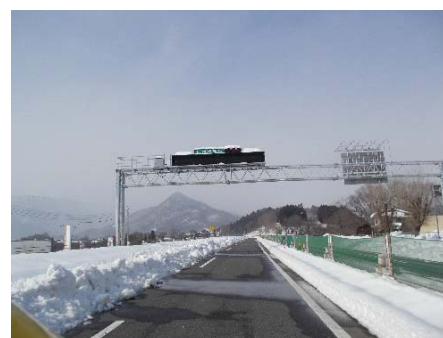
1車線運用の状況
