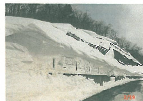
上越橋付近 雪崩防止柵を超え張り出した雪底
