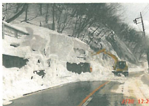
雪底処理作業状況
