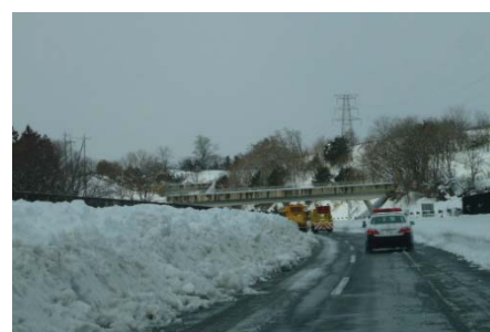
高速隊による除雪状況確認状況
