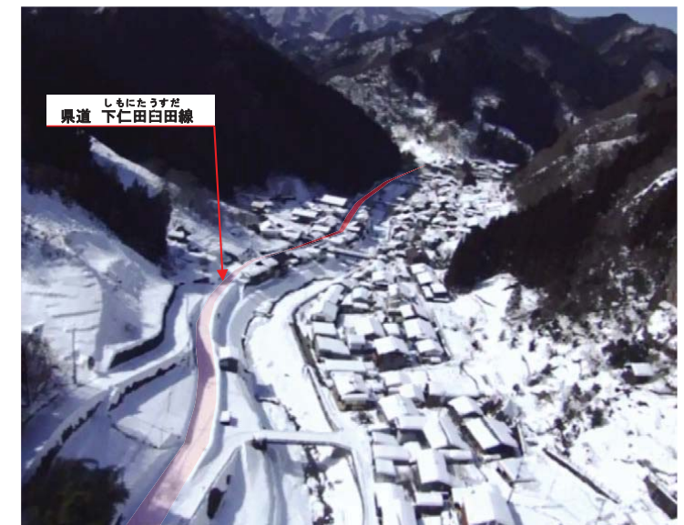
豪雪により孤立した南牧村(羽沢地区)の状況 (H26.2.17撮影：群馬県防災航空隊)
