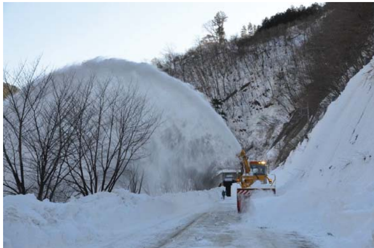
【(国)299号(群馬県管理)除雪状況 (H26.2.22撮影)】
