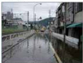
平成18年7月豪雨の被害状況 (諏訪市諏訪4丁目)
