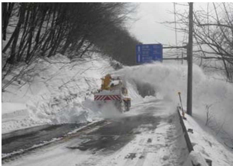
国道17号三国峠 除雪作業状況
