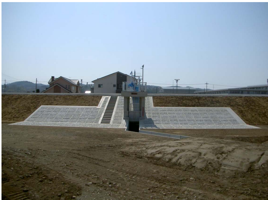
完 成（用水樋管）川表正面より
