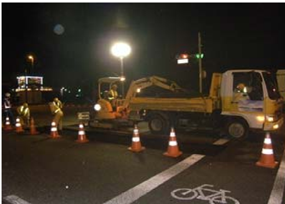
夜間パッチング施工状況
