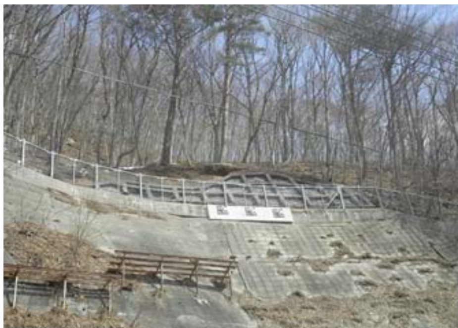
完 成（法面防災）
