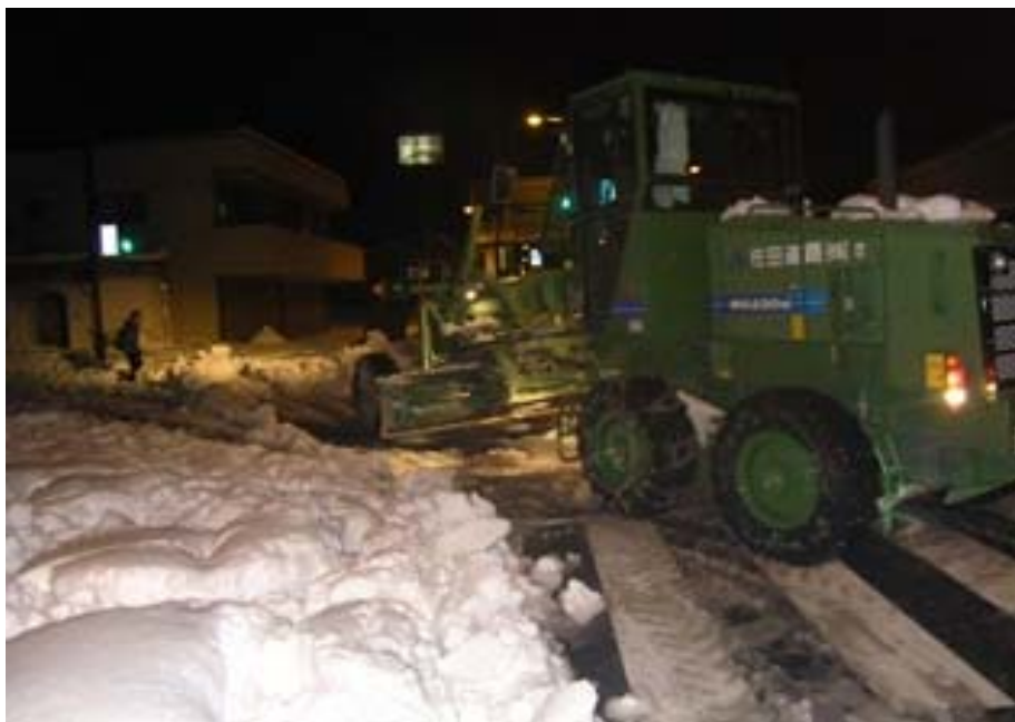
グレーダーによる夜間除雪作業状況
