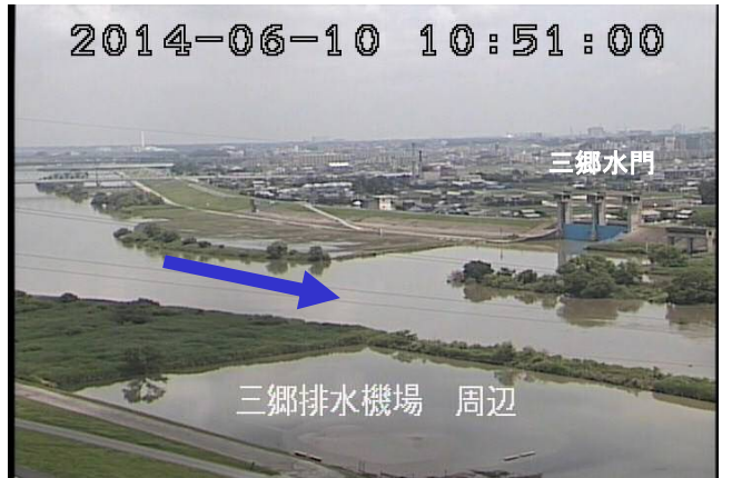
6月10日11時 三郷排水機場周辺状況
