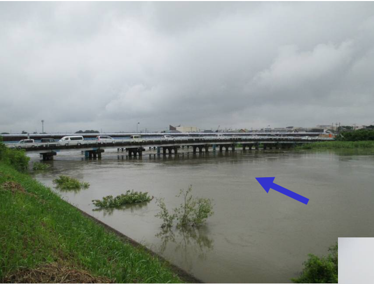
吉川橋付近出水状況
