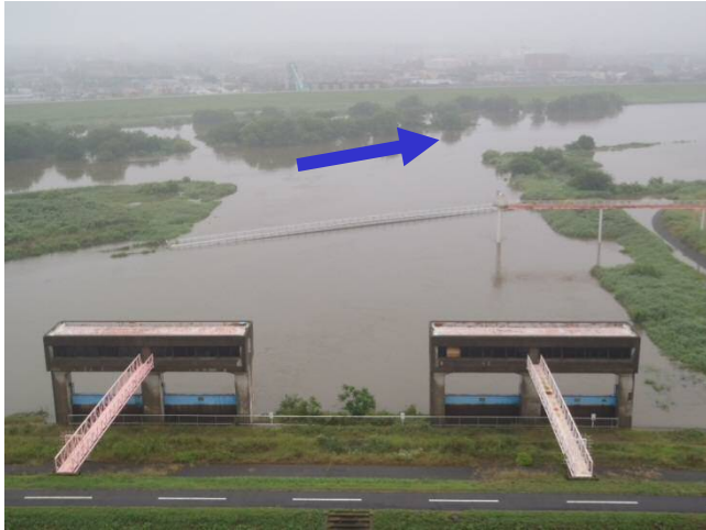
6月8日9時 三郷排水機場周辺状況
