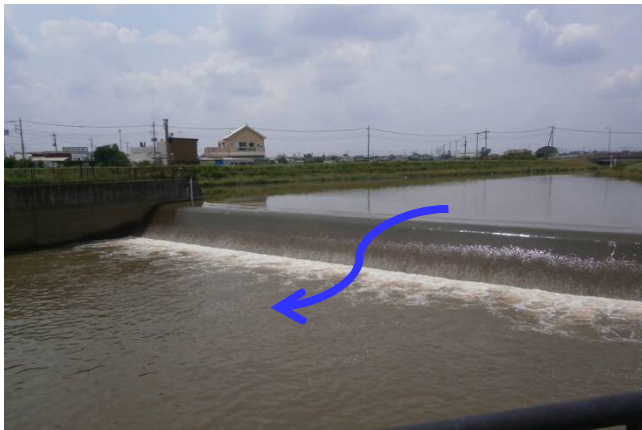
6月10日13時 第3立孔流入状況(倉松川)
