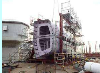
陸上のヤードで上下のパーツを合わせます。
