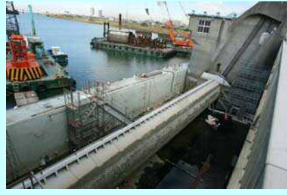
漏水に注意しながら旧ゲート周りの水を抜きます。
