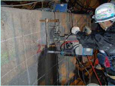
既設のコンクリートにあなを開け、表面をはつります。
