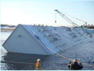
まず、仮の締切りゲートを、堰の上下流に沈めます。
