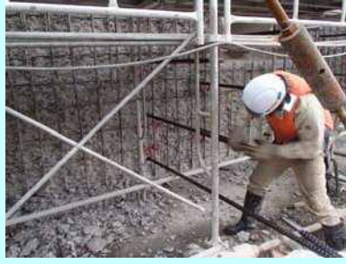
耐震補強材として鉄筋を挿入します。
