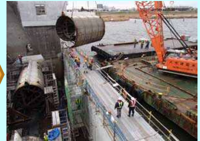
古いゲートを切断し、クレーンでつり上げて撤去します。
