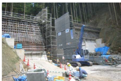
写真-6 同工事現場=同日午後
