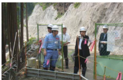
写真-7 同工事現場=同日午後
