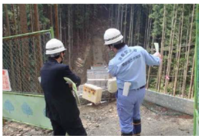
写真-5 同工事現場=同日午後
