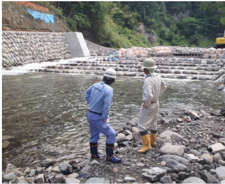
写真-1 一部完成した床固を確認する須藤出張所長(左)と萬屋建設㈱高橋現場代理人(右)=6月16日午後
