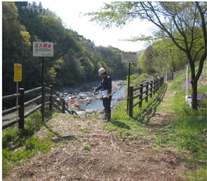
写真-1 安全利用点検を行う大間々砂防出張所・須藤所長＝4月23日午前、神梅護岸(みどり市大間々町上神梅)、出張所職員撮影
