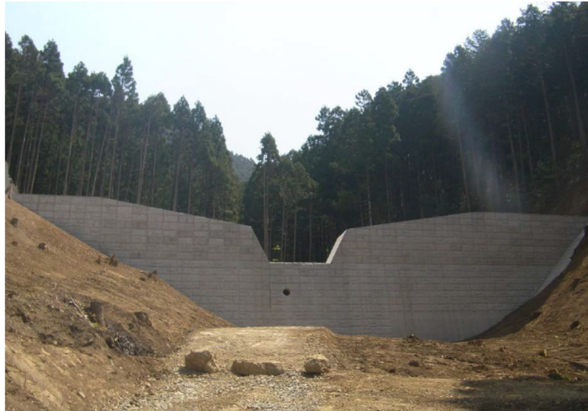
写真-3 大久保沢砂防堰堤=5月下旬、桐生市川内町、沼田土建株式会社森田光氏撮影
