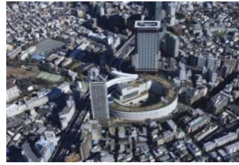
大橋地区市街地再開発事業(目黒区)
