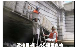
近接目視による橋梁点検
