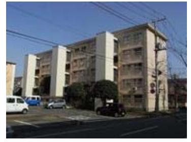
公営住宅等ストック総合改善事業(前橋市)【エレベーターの整備】
