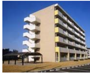
公営住宅整備事業(茨城県)
