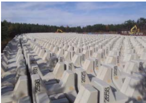
緊急用備蓄資材の整備(平成25年)
