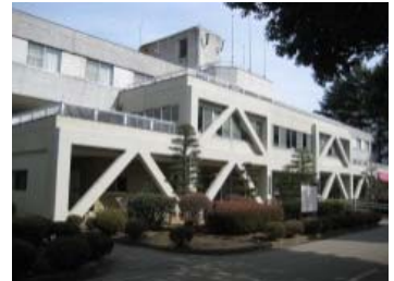
総合運動公園事務所(栃木県)
