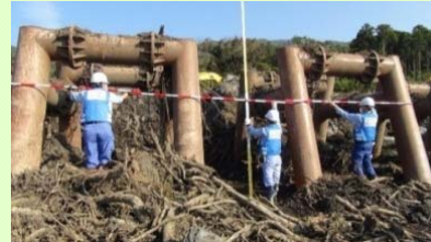
砂防施設の(堰堤)の痕跡調査を実施
