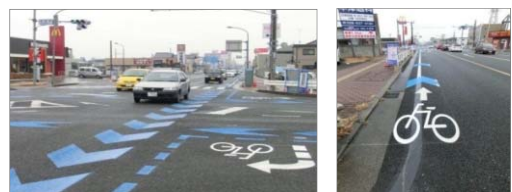
通行位置を示す路面標示設置状況
