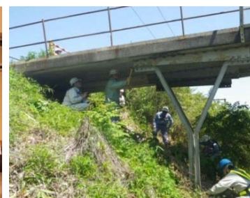
地方公共団体管理橋梁の点検状況 (技術的助言)
