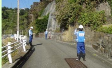
急傾斜地の施設点検
