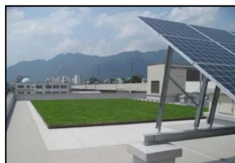
【屋上緑化・太陽光パネル】
