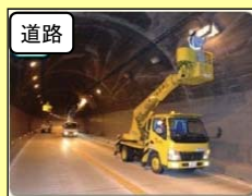
トンネルの点検
