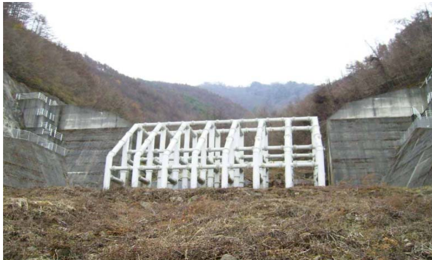
透過型砂防堰堤の例(相模川水系 笹子川 山作沢)
