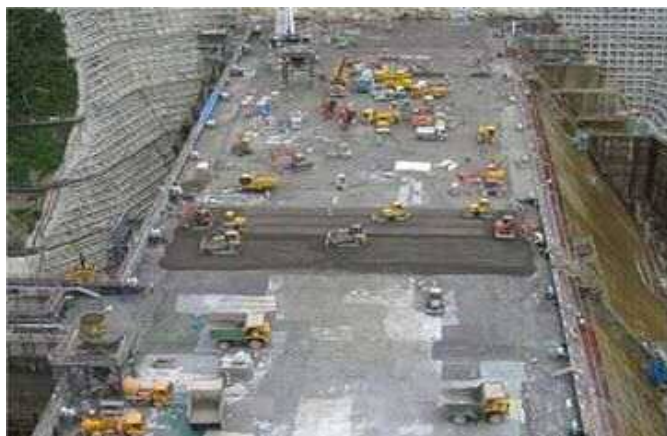
巡航RCD工法によるコンクリート打設状況
