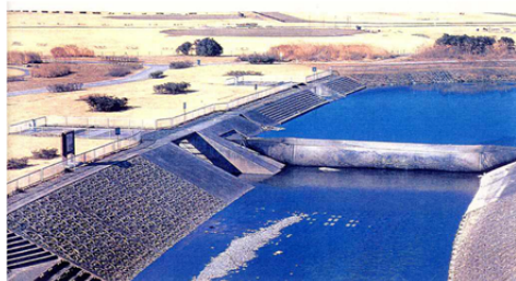
野川浄化施設
